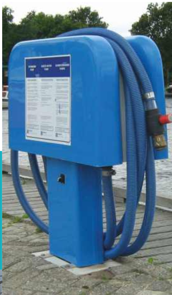
Dużym zainteresowaniem żeglarzy cieszy się znajdująca się w Ekomarinie w Giżycku pompa do odbioru nieczystości z jachtów.
