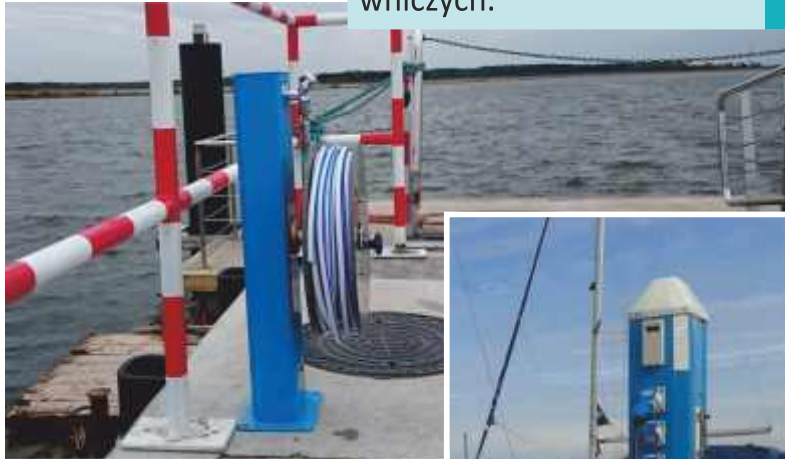
Dużym zainteresowaniem żeglarzy cieszy się znajdująca się w Ekomarinie w Giżycku pompa do odbioru nieczystości z jachtów.
