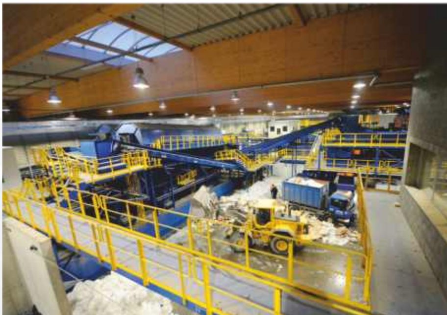
Widok na sortownię odpadów, gdzie pracuje ładowarka Volvo z naszą wagą Loadtronic 3.
