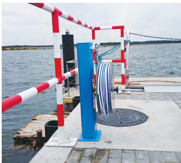
Ruchome koła do nawijania 33 metrów węża do wody pitnej zapewniają łatwą obsługę systemu dystrybucji wody oraz zapobiegają pozostawianiu na pomoście płataniny przewodów.
