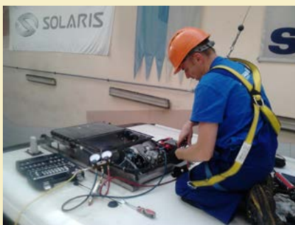
Naprawa klimatyzatora KL20KDE na autobusie Solaris.
