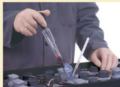
Wykonanie czynności konserwacyjnych pozwala utrzymać akumulatory w optymalnym stanie.
