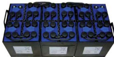
Automatyczny system uzupełniania wody „Hawker aquamatic” zapewnia niewielki zakres obsługi baterii perfect rail.
